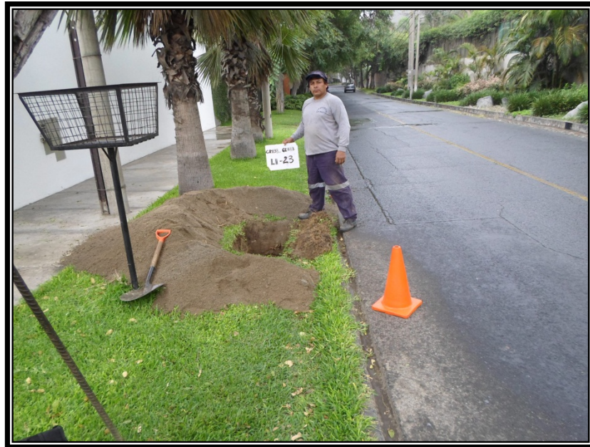
Foto N° 17 y 18: Ubicación de la calicata LI-23 se presenta un material removido conformado por arenas de grano grueso, no plástica, de color beige, húmeda, con gravas angulosas de tamaño 1\frac{1}{2} ", en estado semicompacto.
